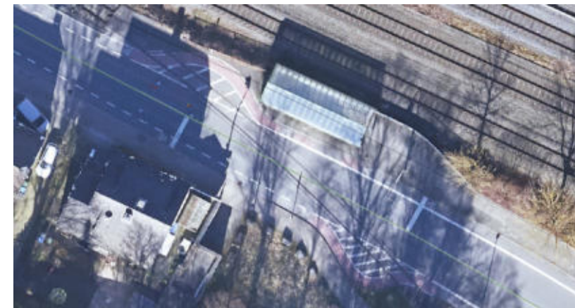
Kleinbahnstraße 2-3, Querung Radweg/Bahnanlage
